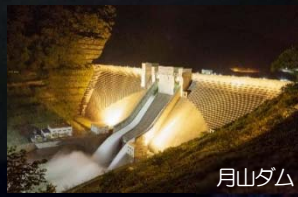
湯田貯砂ダム
